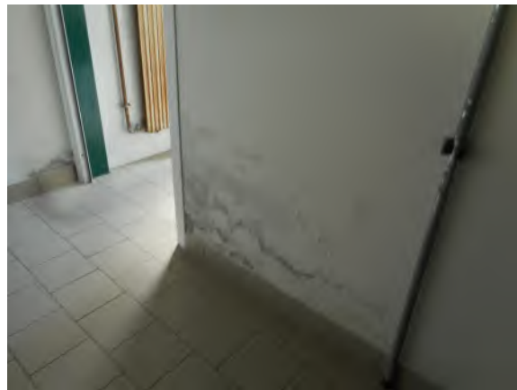
Capannone interno -Servizi igienici PT (lato est)- dettaglio infiltrazioni
